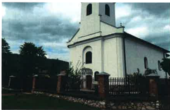
Obr. 1: Monitorovaná zóna C, Kostol Dvorníky
