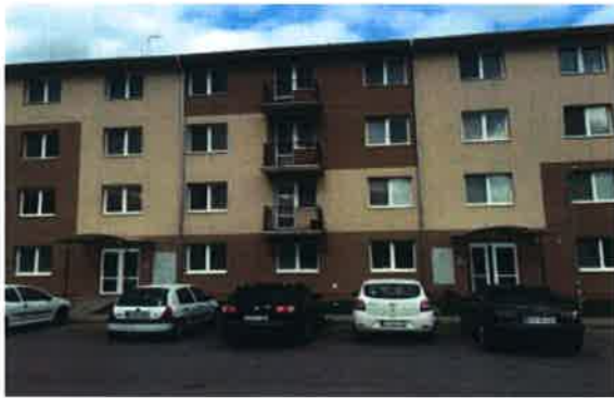
Obr. 1: Monitorovaná zóna J1, Obecné nájomné byty
