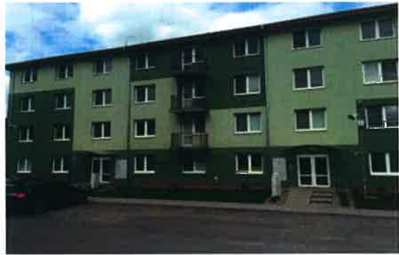
Obr. 2: Monitorovaná zóna J2, Obecné nájomné byty
